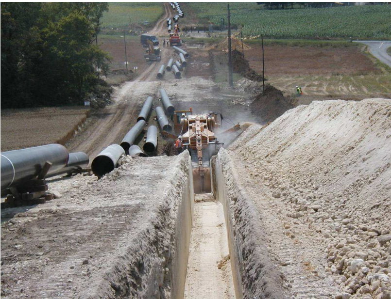
Figure 5 - Chantier de pose d'une canalisation
